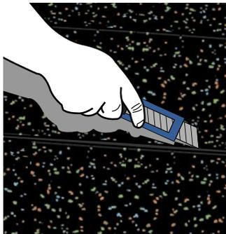
5. Por último, **se deben de rematar todas las uniones del piso con el muro cortando el material con cúter**.
